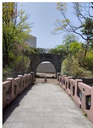
柳橋から見た石造アーチ橋。石だけで作られたものは、長崎の眼鏡橋など九州に多く見られ、関東地方ではあまり見受けられないようです。
